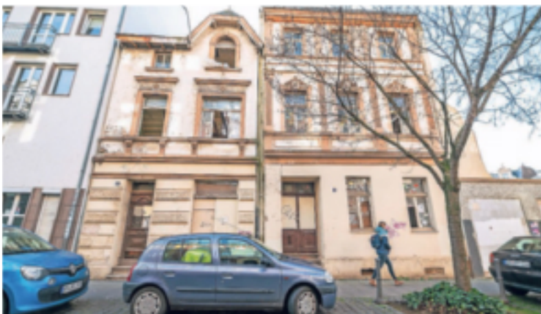
Die beiden Häuser an der Franzstraße stehen nach einem Gerichtsentscheid nicht mehr unter Denkmalschutz.
