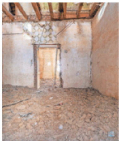
Blick von außen durchs Fenster: Die Räume sind entkernt.
